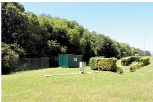
Vista actual da depuradora do polígono industrial
