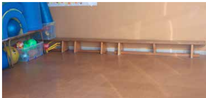
Colocación de cortiza no chan e nas paredes.
