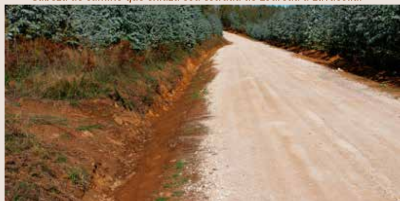
Apertura de gabias e limpeza de salvagabias.
