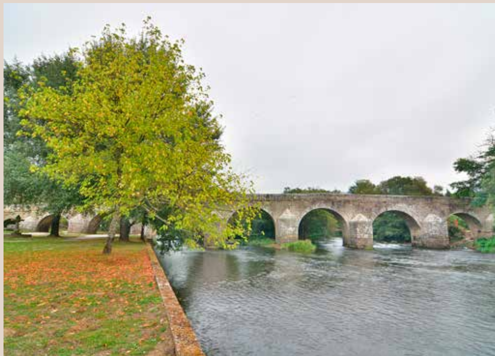
Vista actual da ponte despois da realización dos traballos de limpeza.
