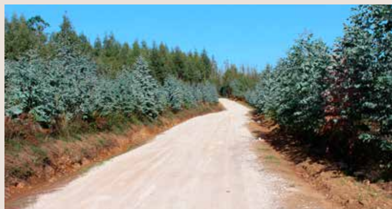
Na imaxe é visible a mellora da capa de rodaxe.
