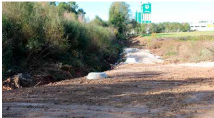
Pozos estanco que facilitan a conexión dos colectores actuais á rede xeral da depuradora.
