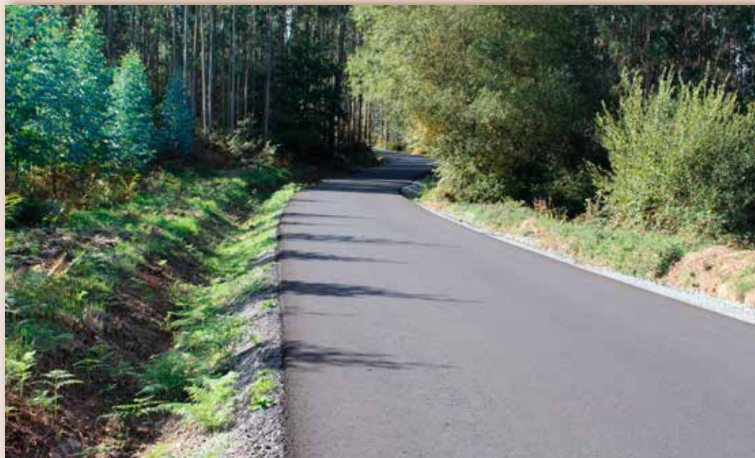
Estado actual do vial despois da realización das obras.
