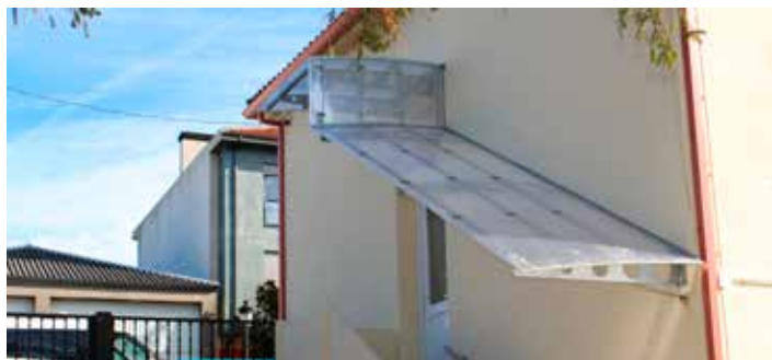
Instalación de cubrimento nas entradas á escola unitaria.
