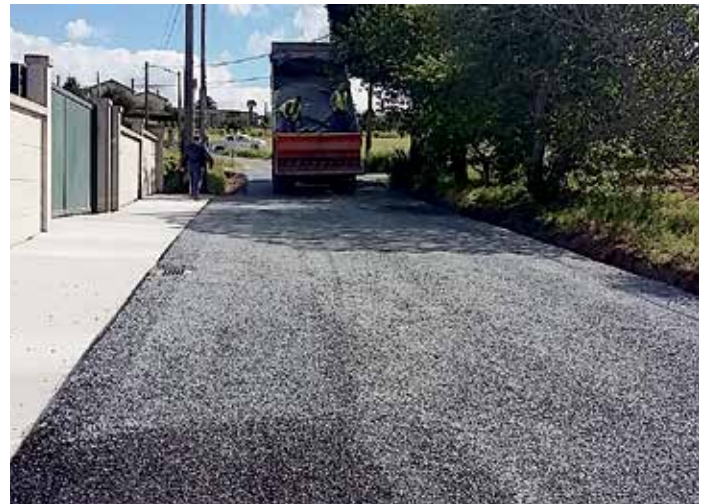
O Concello de Boqueixón destina a obras sete de cada dez euros do POS+2107, o que supón un investimento de 447.000 euros
