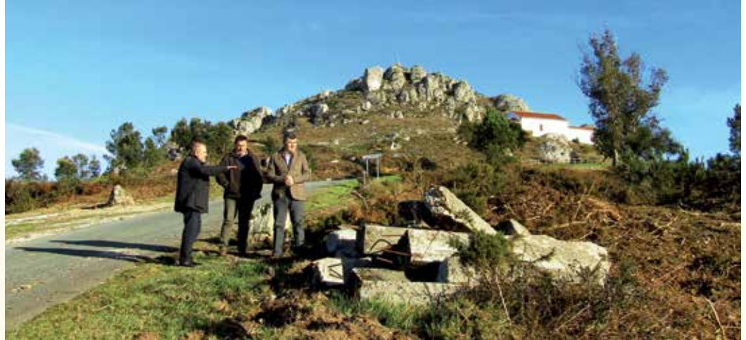
O alcalde de Boqueixón, Manuel Fernández, e o delegado da Xunta na Coruña, Ovidio Rodeiro, supervisan a demolición dunha estrutura na contorna do Pico Sacro
