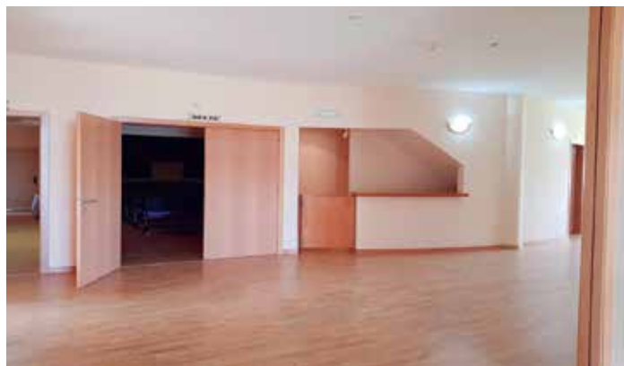
Vista da reforma da entrada, coa renovación de chans e carpintería
