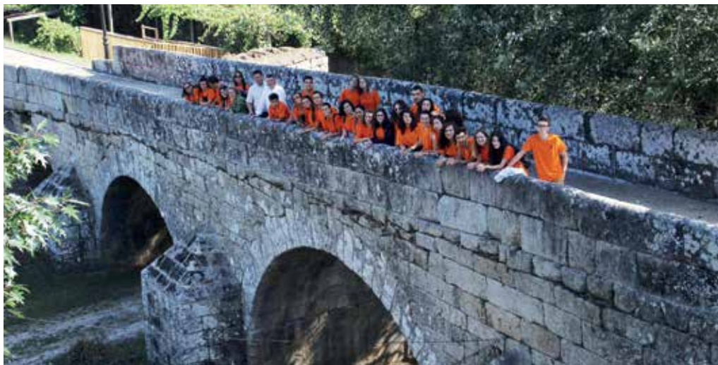
As actividades de voluntariado centráronse na limpeza da Ponte Ledesma e en accións formativas e divulgativas
