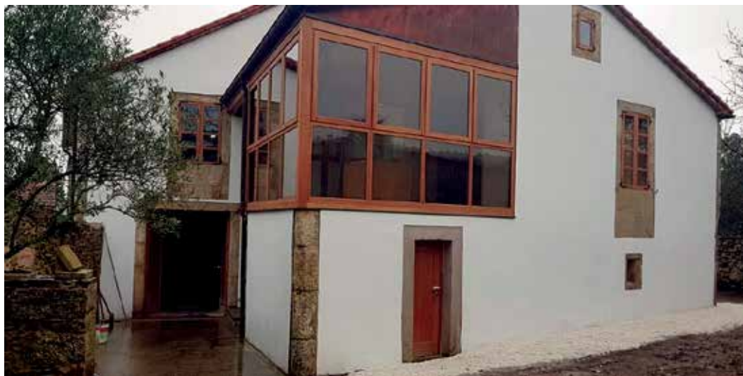
Vista da renovada fachada do Centro de Interpretación do Pico Sacro, que foi obxecto de varias melloras
