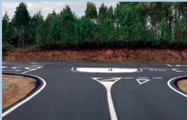
A renovada intersección coa estrada provincial mellora a seguridade viaria
