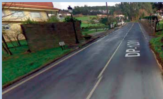
Vista parcial da estrada provincial na que se prevé habilitar a senda peonil
