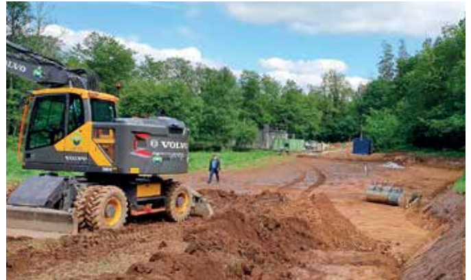
O rexedor visitou as obras que se están a acometer para a EDAR de Sergude
