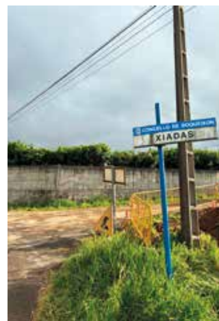
Obras de saneamento en Xiadás
