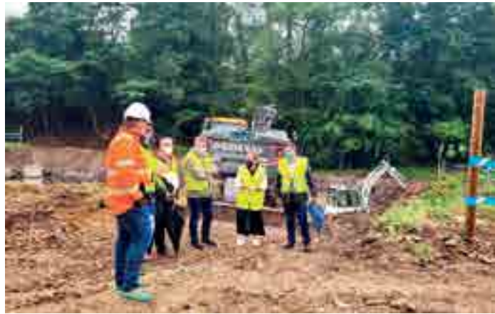
Visita do alcalde e a conselleira de Infraestruturas ás obras da nova depuradora
