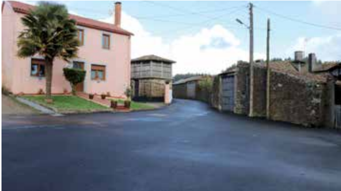
Acondicionamento do acceso ao interior do lugar de Pena (Loureda)
