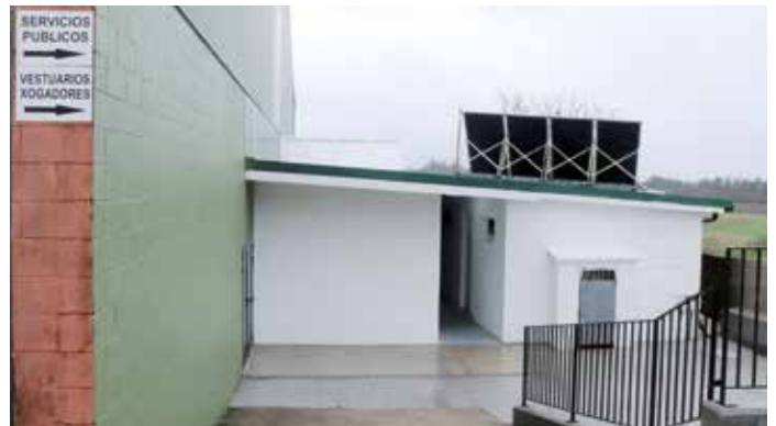
Melloras nos vestiarios do pabillón polideportivo do Forte
