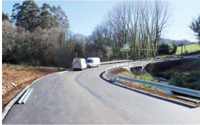
PONTE DE QUIÁN. As obras da nova ponte de Quián están case finalizadas, a falta da instalación das barandas de protección.
