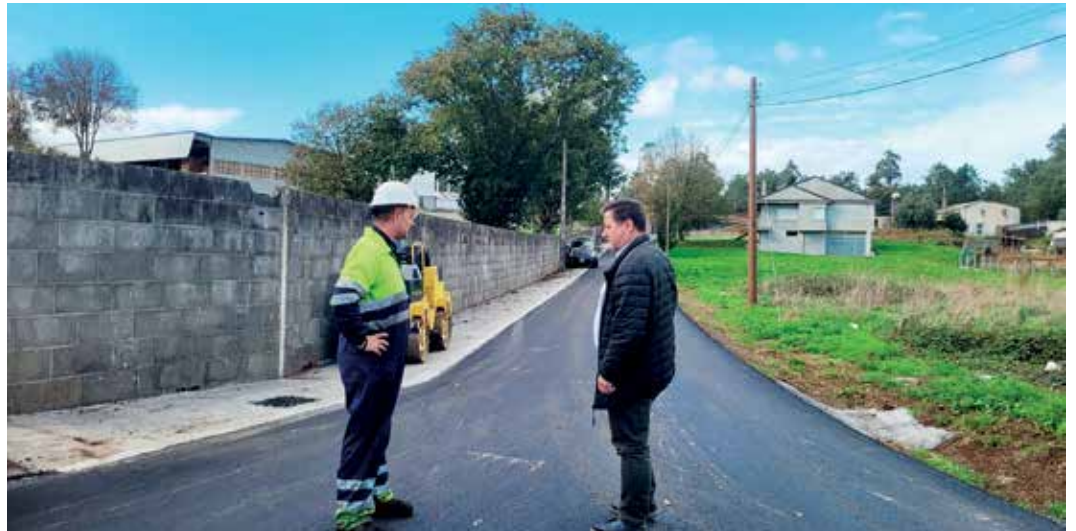
O alcalde comproba a boa marcha do asfaltado dos viarios perimetrais do polígono de Camporrapado
