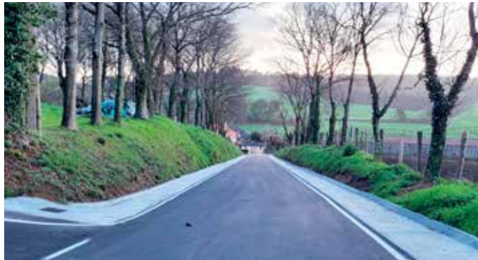
Aglomerado de Casalpegito á Moa, onde se mellorará o viario cara á Pena
