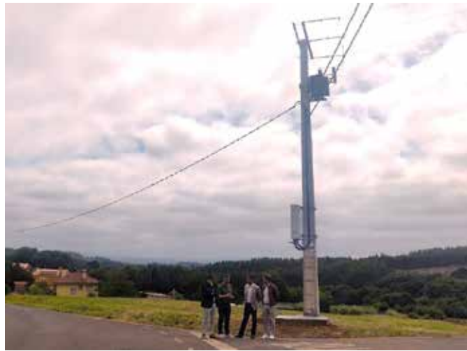
O alcalde visitou as obras xunto ao delegado de UFD na Coruña
