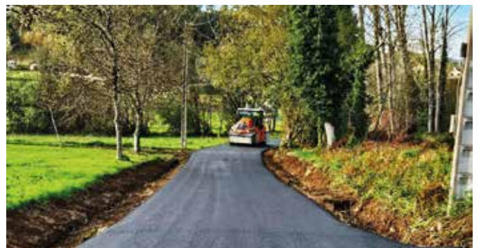
Obras do Plan de mellora de camiños de acceso a parcelas agrícolas 2023-24
