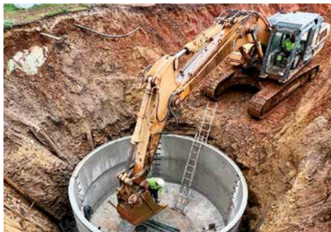
Obras de instalación do novo decantador da depuradora de Pumariño
