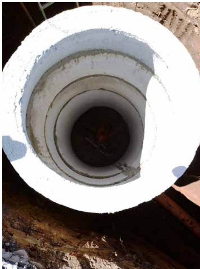
Actuación de saneamento realizada este ano en Quián
