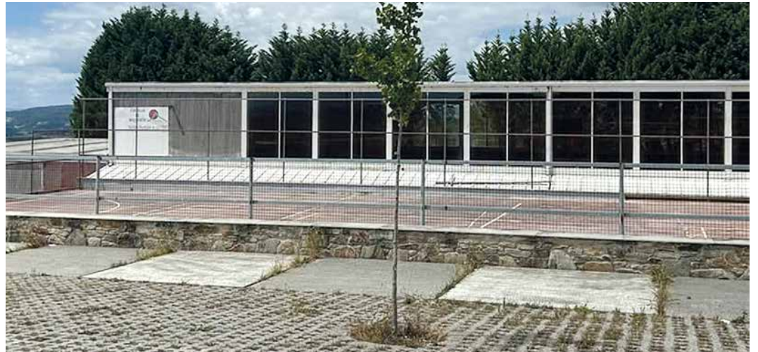
O Concello agarda poder comezar coas obras de mellora do polideportivo de Lestedo o próximo mes de outubro
