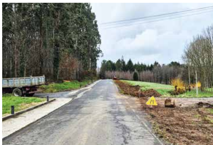
Inicio das obras de ampliación da rede de abastecemento no Burgo e Outeiro
