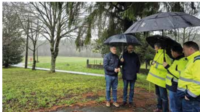
Visita de replanteo das obras de saneamento en Ardilleiro Pequeno (A Granxa)
