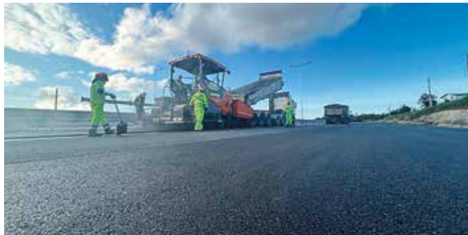
O microaglomerado é máis duradeiro e evita a gravilla do dobre riego
