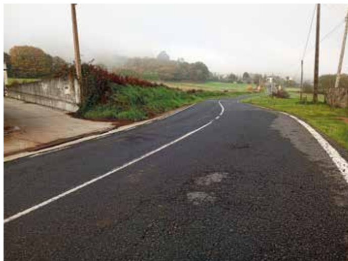
As obras mellorarán a capa de rodaxe da AC-261 ao seu paso por Boqueixón
