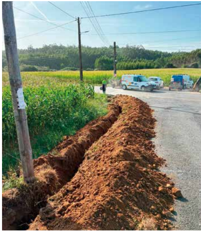
Obras de conexión dunha vivenda en Loureda, cun ramal de 100 metros
