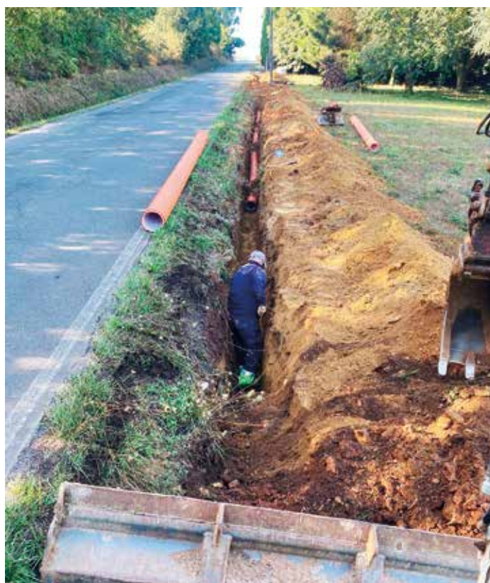
Obras de ampliación da rede de saneamento en Quián (Sergude)
