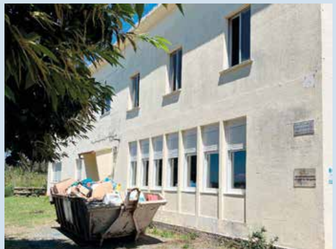
Para evitar molestias, as obras acometeranse durante as vacacións de verán
