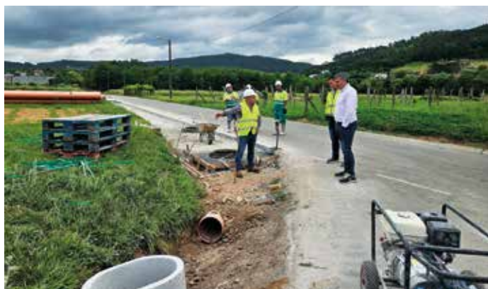
Alcalde e concelleiro de Obras comprobando os avances en Ponte Ledesma-Noente
