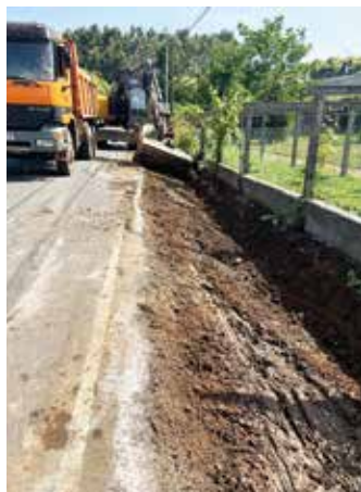
Inicio das obras na senda de Boqueixón
