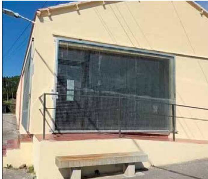
Melloras no illamento térmico da fachada exterior do local social de Lamas
